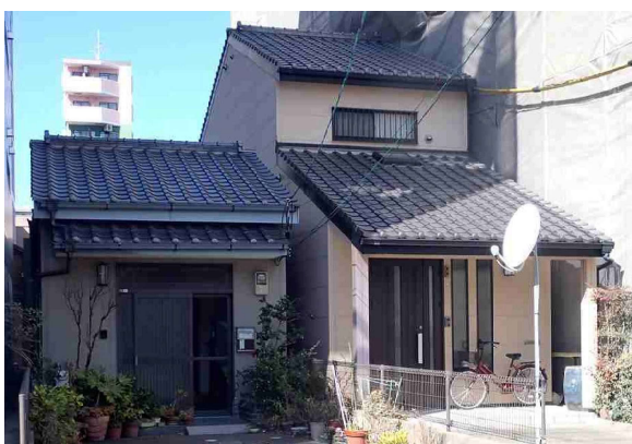
道路に向けた勾配屋根の事例
