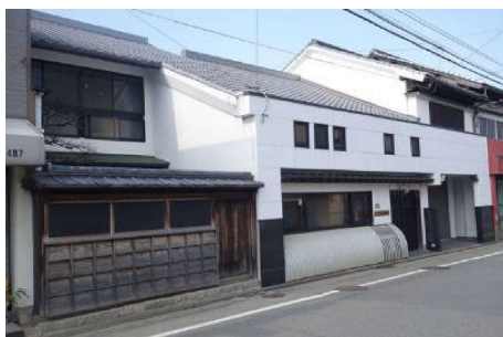
②町家を改修して利用している建築事例。
