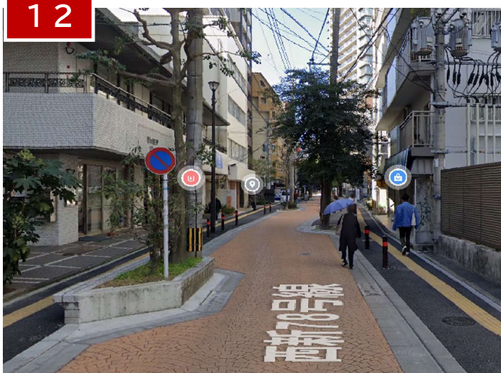
西新オレンジ通り商店街（終日一方通行） 幅員約7～10m（車道約4～5m、歩道約3～5m）
