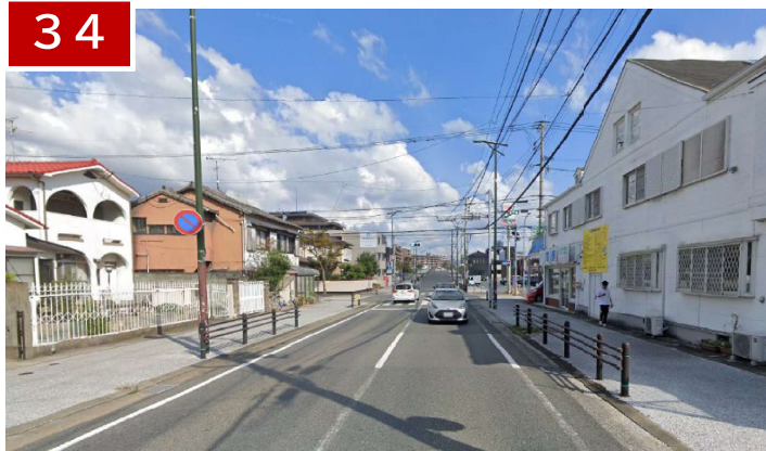
原田箱崎線 幅員約16m
