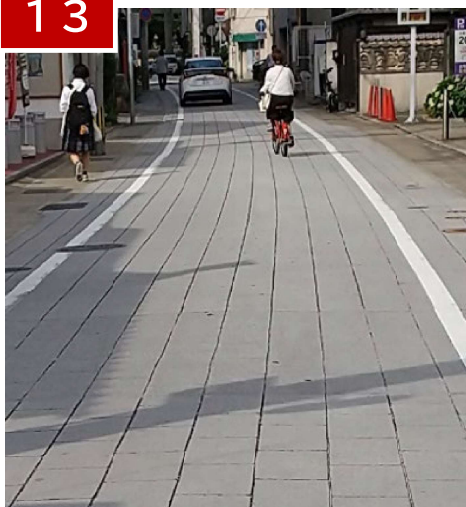
櫛田表参道 幅員約7m（終日一方通行）
